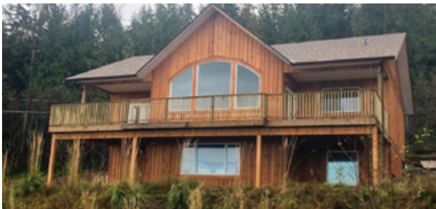
Maison garantie par le Fonds – Première Nation de Skidegate
